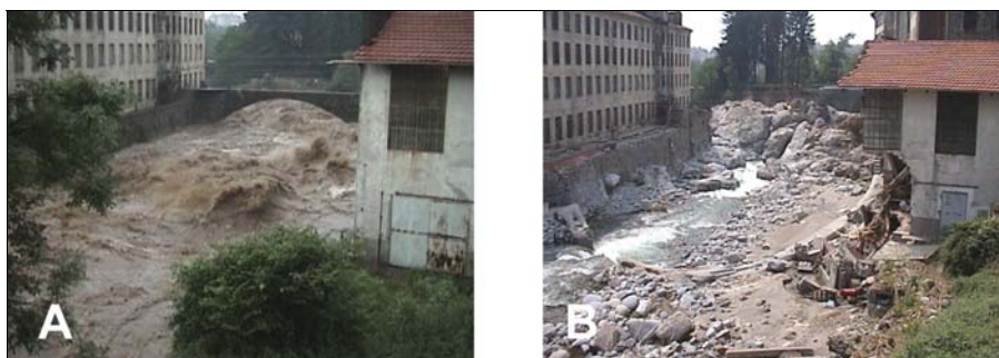
Fig.15. Comune di Biella, vecchia area industriale (ex Lanificio Pria) vista da monte. La foto A mostra la situazione dei fabbricati prima dell'arrivo della massima piena del torrente Cervo. La foto B , scattata il giorno seguente, mette in evidenza i danni arrecati ai fabbricati, "il Ponte delle Signore" asportato dalle acque del Cervo, le profonde erosioni laterali e la mobilitazione del materiale in alveo. Sullo sfondo l'area attrezzata a giardino.
