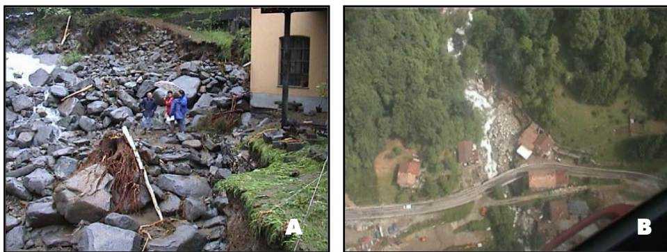
Fig.26. Comune di Quittengo, loc. Fucina. Foto B : Violenta attività torrentizia del rio Rialmosso. In sinistra idrografica si nota l'accentua erosione che ha asportato le difese spondali, minacciando l'abitazione (Foto A ).
