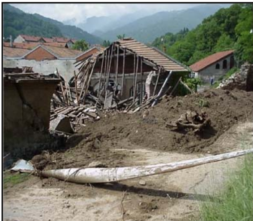
Fig.13. Comune di Andorno Micca: la colata che ha danneggiato l'edificio industriale.
