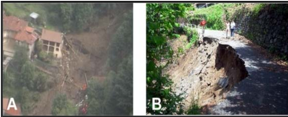
Fig.24. Comune di Quittengo, fraz. Roreto-Maciotta. Foto A : vista aerea del percorso della colata e dell'area più danneggiata (due edifici di civile abitazione e la strada distrutti in fraz. Caciotta-Vutun). Foto B : particolare della nicchia di stacco della frana che ha interrotto la strada comunale di comunicazione tra il capoluogo e la fraz. Roreto e che ha successivamente raggiunto la sottostante frazione.
