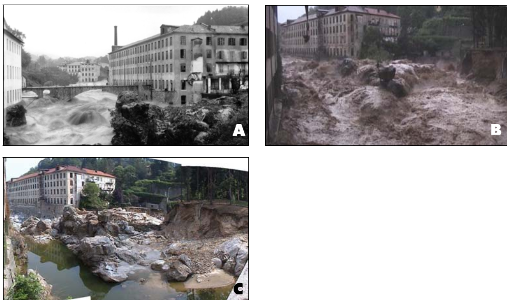
Fig.14. Comune di Biella; le tre fotografie in sequenza mostrano l'area industriale (ex Lanificio Pria) situata sulle sponde del T. Cervo. Foto A (archivio fondazione Sella): foto storica della piena del 1908, sullo sfondo è visibile "il Ponte delle Signore" risalente all'inizio del 1800, distrutto durante l'ultima piena. Foto B : la stessa area durante la piena del 2002, si nota l'altezza raggiunta dalle acque che hanno coperto la parte terminale dell'area attrezzata a giardino. Foto C : foto scattata il giorno successivo, in primo piano la vistosa erosione che ha asportato parte del giardino.
