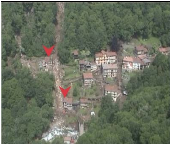
Fig.25. Comune di Quittengo, loc. Tomati: la foto aerea mostra la colata più occidentale che ha semidistrutto i due edifici indicati con le frecce rosse.
