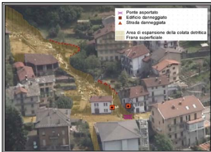
Fig.20. Comune di Campiglia Cervo, la massa di acqua e detriti proveniente dal rio Borghesi ha invaso parte della frazione omonima. La foto mostra le due case danneggiate gravemente, il ponte asportato e le profonde erosioni laterali.
