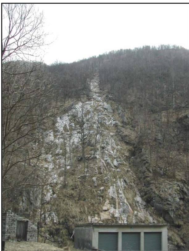
Fig.16. Comune di Rosazza: frana per saturazione e fluidificazione della copertura superficiale che si è innescata poco a valle del cimitero.
