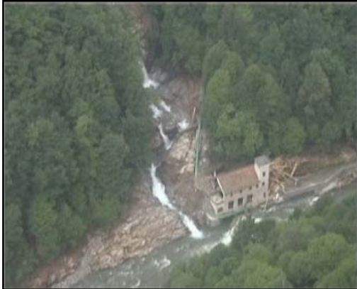
Fig.12. Comune di Sagliano Micca: vista aerea della centrale danneggiata dal T. Cervo e del rio Luchiana che presenta l'alveo completamente ripulito dal materiale.
