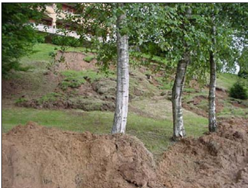
Fig.5. Valle Elvo: esempio di frana superficiale innescata ai piedi di un edificio.
