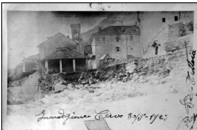
Fig.34. Comune di Rosazza. In località Tettoia, le acque in piena del T. Cervo produssero una pronunciata erosione di sponda con asportazione di parte della strada provinciale. (tratta da http://www.rosazza.net )
