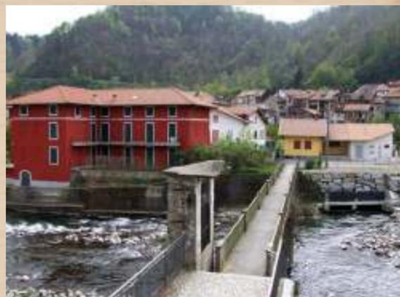
Lo stesso punto del disastro di Coggiola come appare oggi: argini più ampi e sicuri, la pedanca di legno sostituita da un passerella di cemento. Particolare della cappelletta costruita a guardia del ponte: si riconosce identica nella fotografia del 1878
