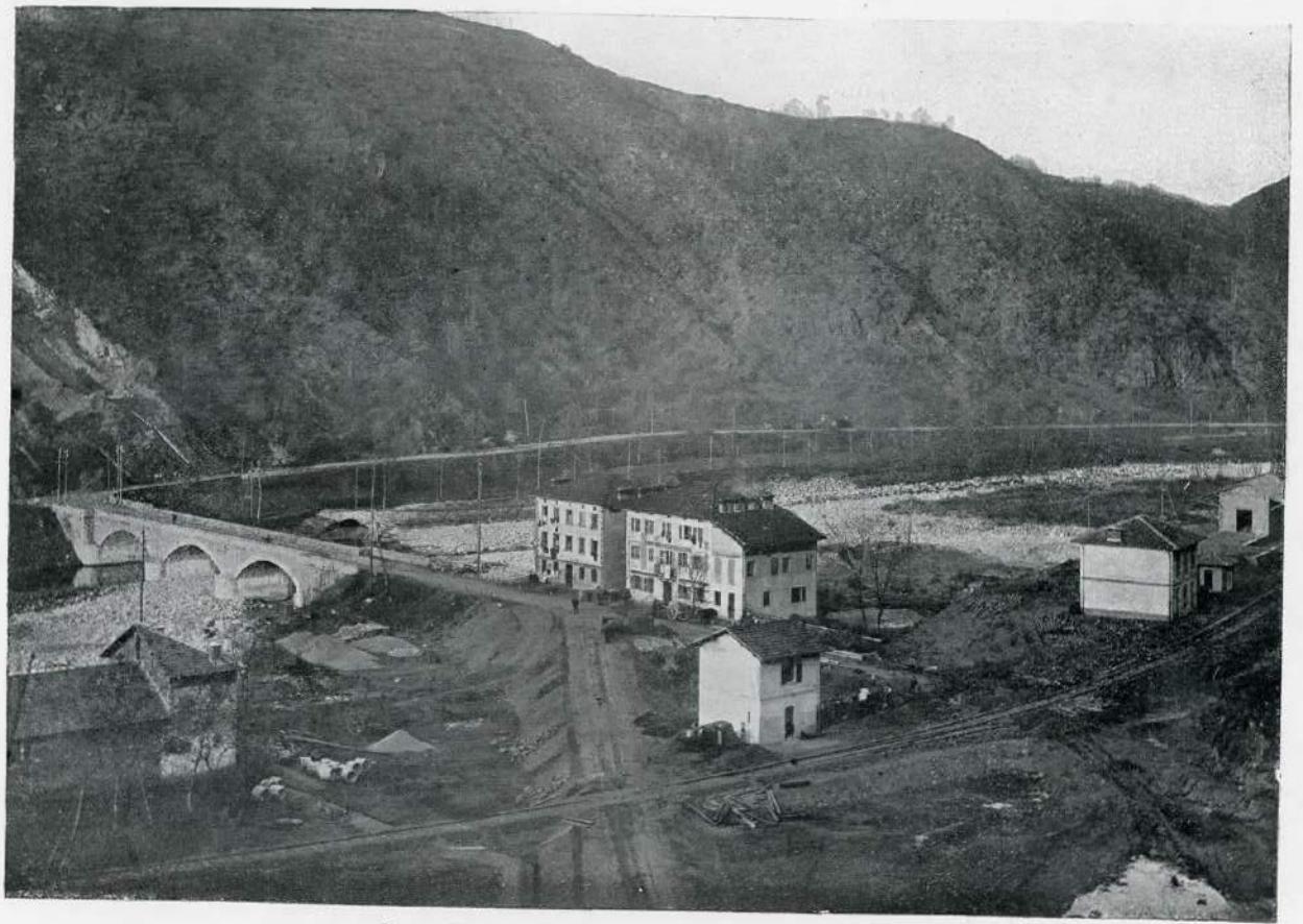
Ponte Provinciale e Stazione Ferrovia (Pianceri).
