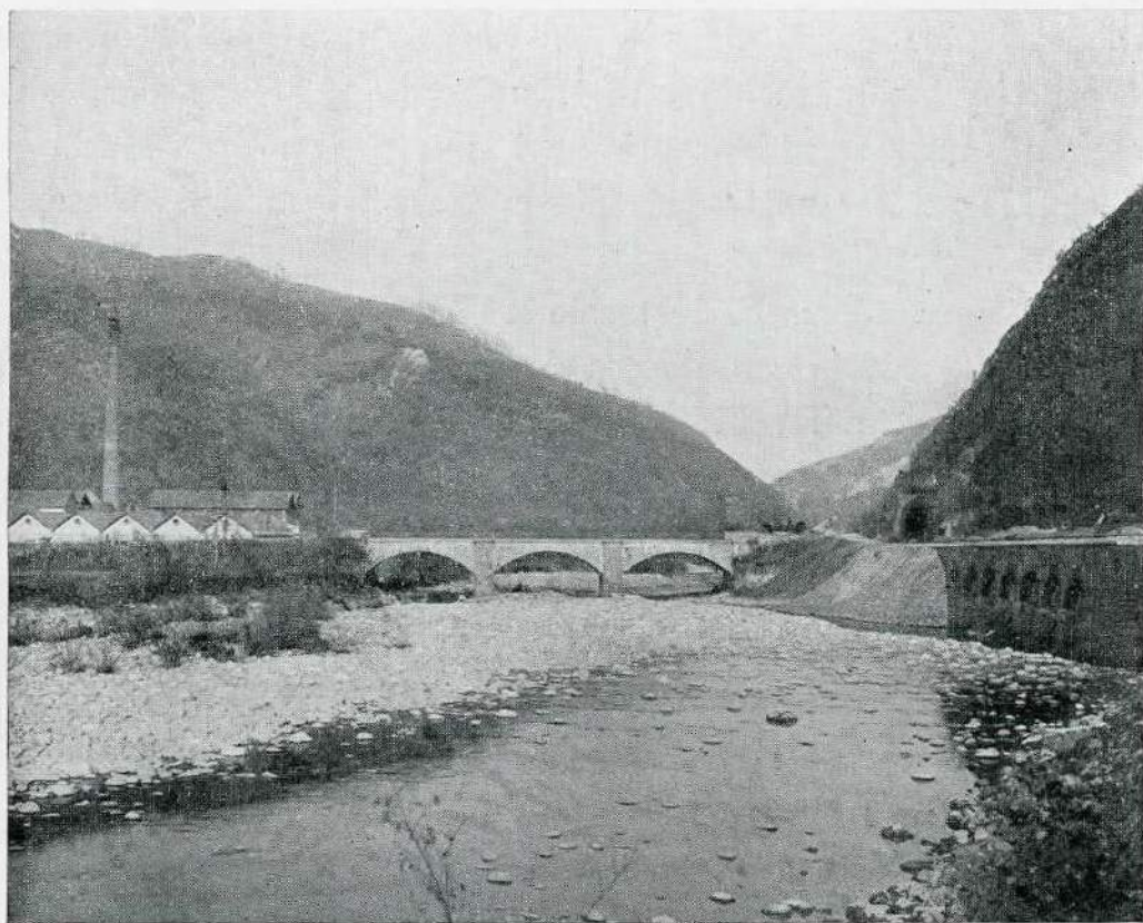
Ponte di Crevacuore e Galleria Squisone.
