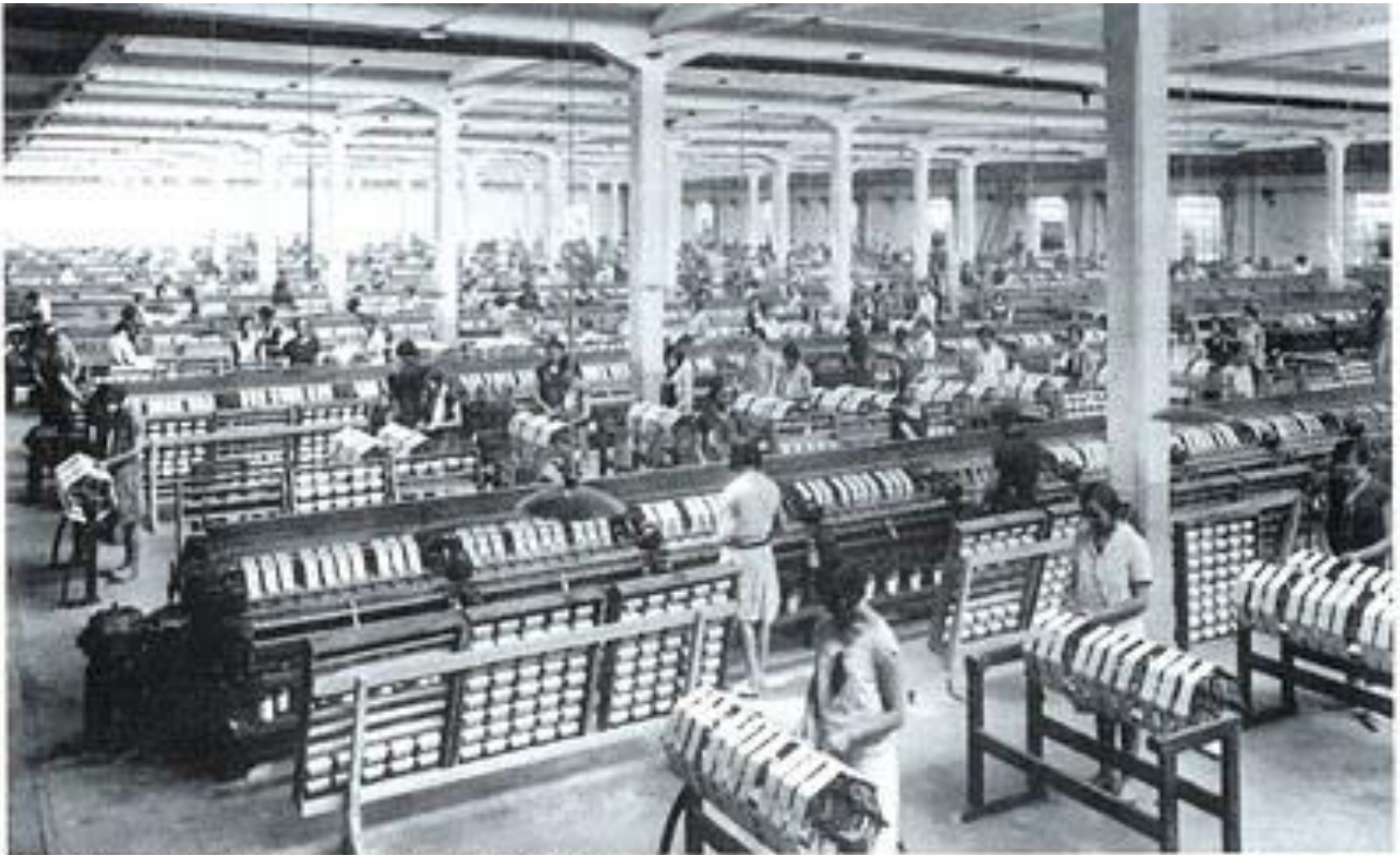
Snia Viscosa. Sala di aspitura per convertire il filato in roccetti in matasse.
