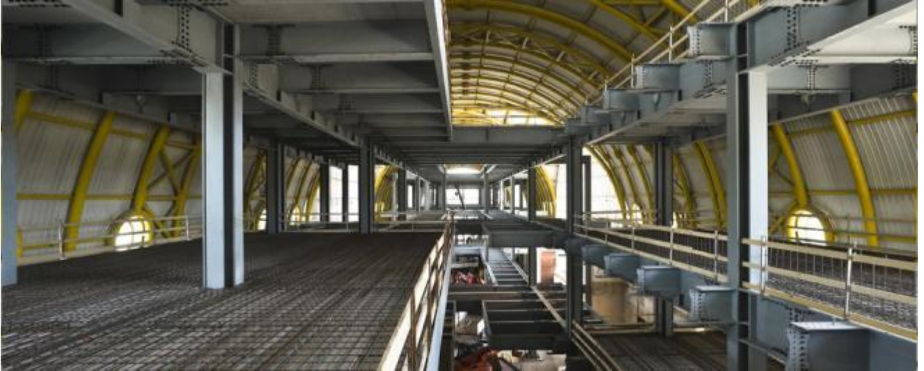
Interno del Palazzo Gualino, particolare del sottotetto ristrutturato.
