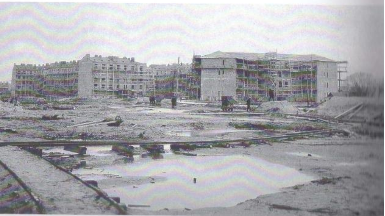
21. San Pietroburgo. Edifici in costruzione ad opera della Soc. Riccardo Gualino, 1914
