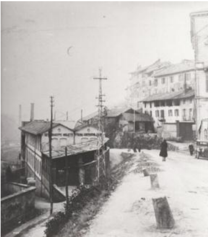
1933 – La prima "FABBRICA DELL'ORO" Giuseppe Gualino ceduta dopo la costruzione della nuova fabbrica in Via Serralunga alle officine costruzioni in ferro di Giuseppe Miglietti. Alla fabbrica fu aggiunta una ciminiera che venne abbattuta verso la fine del 900. Si noti sulla destra della strada innevata una Fiat Balilla e la "FABBRICA DELLE BOTTI DI ROVERE" ora sede dell'Associazione Culturale NOI BIELLESI e di altre attività.
