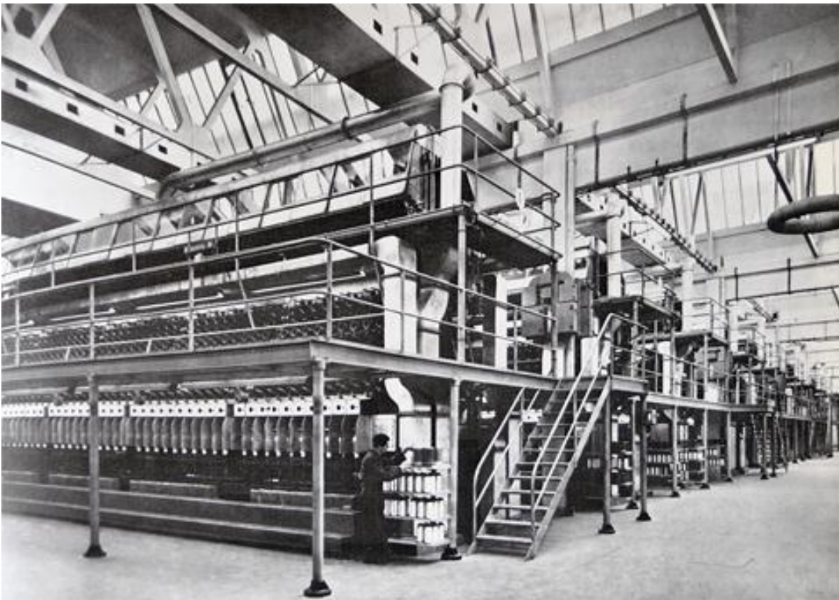
Impianti della SNIA a Varedo.
