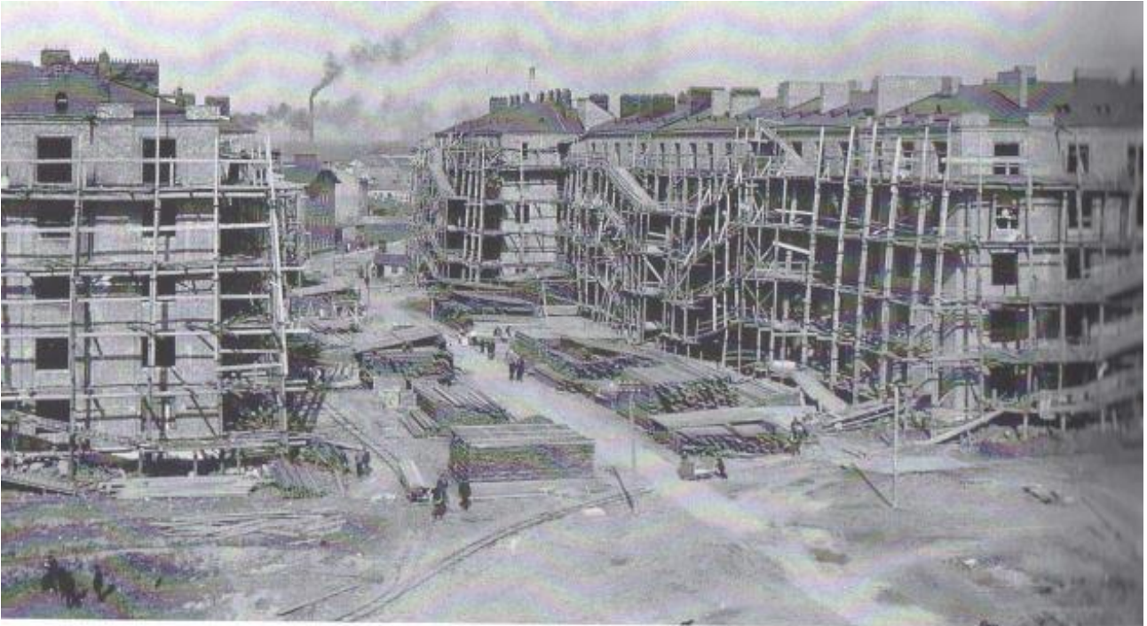
20. San Pietroburgo. Edifici in costruzione ad opera della Soc. Riccardo Gualino, 1914
