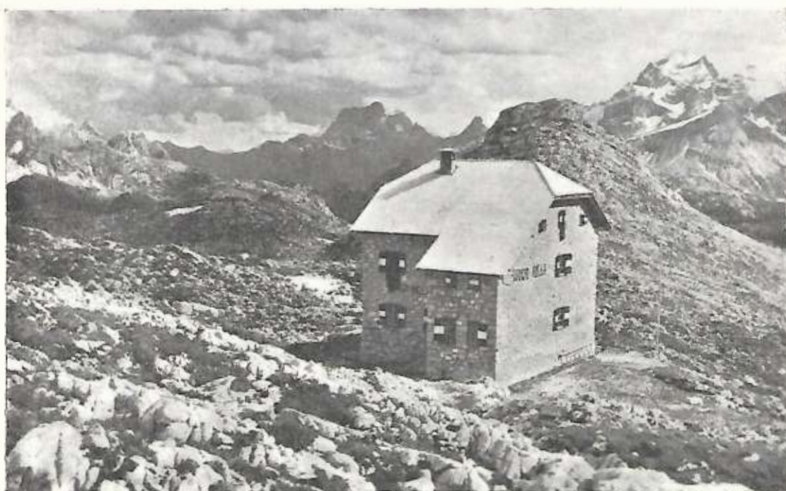
Il Rifugio Biella presso la Croda del Lago. (Dolomiti Ampezzane).
