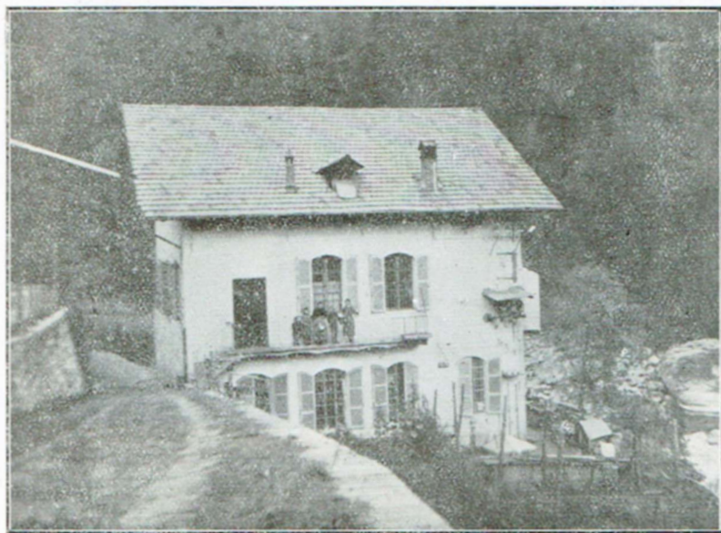
Centrale Idroelettrica Valsessera in regione Cavallero
