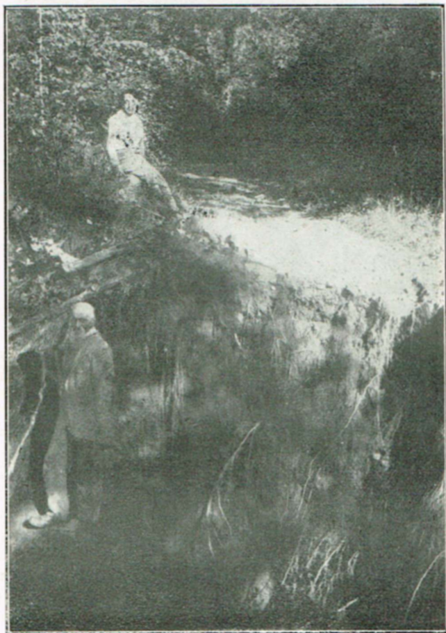
Vincenzo Ormezzano e figlia Gina sul posto ove qualche giorno prima esisteva il ponte, in cemento armato, di m. 4 x 8, sul torrente Venalba, asportato dalle acque il 27 giugno 1927
