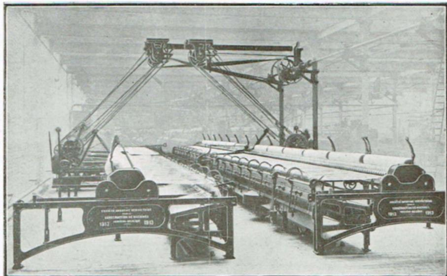
Fig. 18. — Selfacting della Casa Houget a cannelle mobili su carrello e fusi fissi
